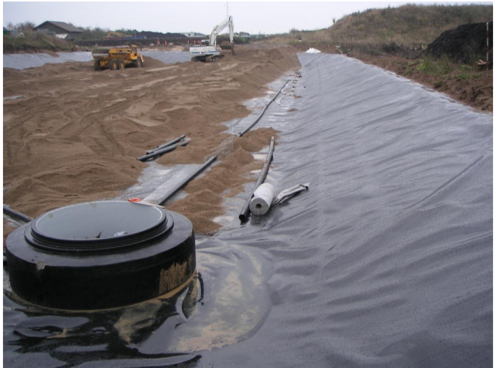
Պատկեր 29 Բարձր խոռոչյան պոլիէթիլենի վրա 0.25 մ դրենաժայի ելքերի տեղադրում
