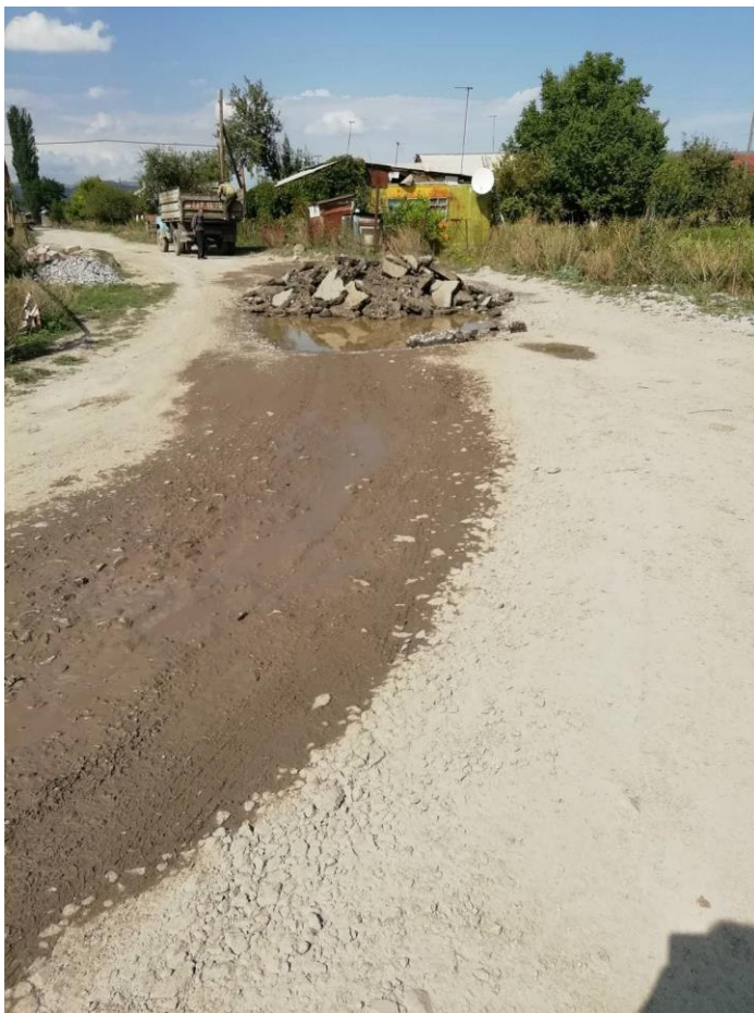
Նկար 1 Երթևեկելի մասի քայքայված հատված Ախուրյանում
