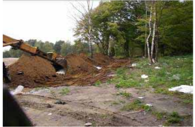
Լուսանկար 14. Մեկուսիչ լիրաթմբի կառուցումը և ամրապնդումը աղբանոցի հյուսիս-արևելյան հատվածում
