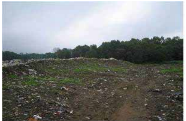
Լուսանկար 10. Աղբանոցի հյուսիսային մասում կառուցված լիրաթումբը: Լիրաթմբի կառուցման հիմնական նպատակն է կանխել աղբի հետագա տարածումը դեպի մոտակա անտառը
