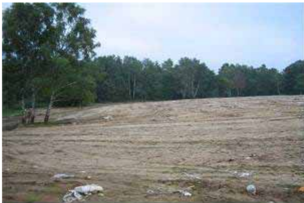
Լուսանկար 9. Կրուզլովո աղբանոցի խտացված, ձևավորված և ծածկված հյուսիս-արևմտյան հատվածը: Տեղամասի թեքությունը (զմբեթածև դասավորվածություն) նպաստում է անձրևաջրերի հոսքի բնական հեռացմանը, կանխելով թորանի առաջացումը
